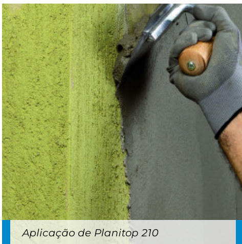
Aplicação de Planitop 210 com talocha
